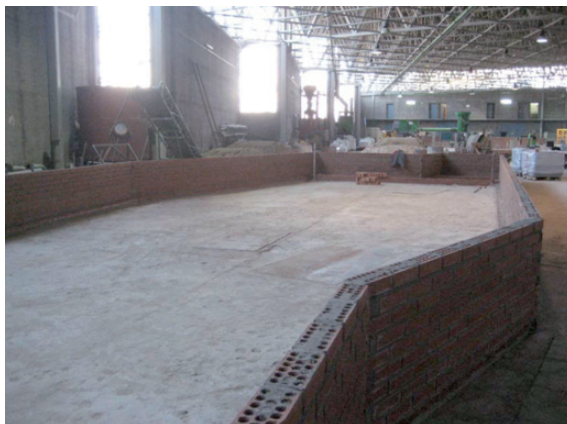
Construcción de muros perimetrales
