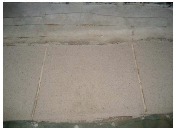
Lecho móvil resultado de mastrar el árido entre dos plantillas
