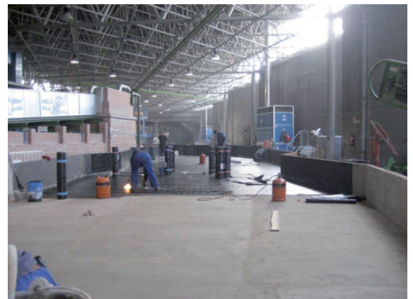
Impermeabilización interior mediante tela asfáltica
