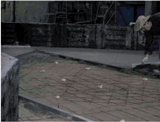
Hormigonado de la solera
