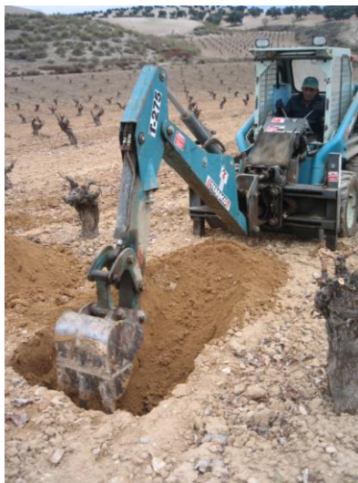
Fotografía 1.2. Excavación para abrir la calicata en uno de los viñedos
