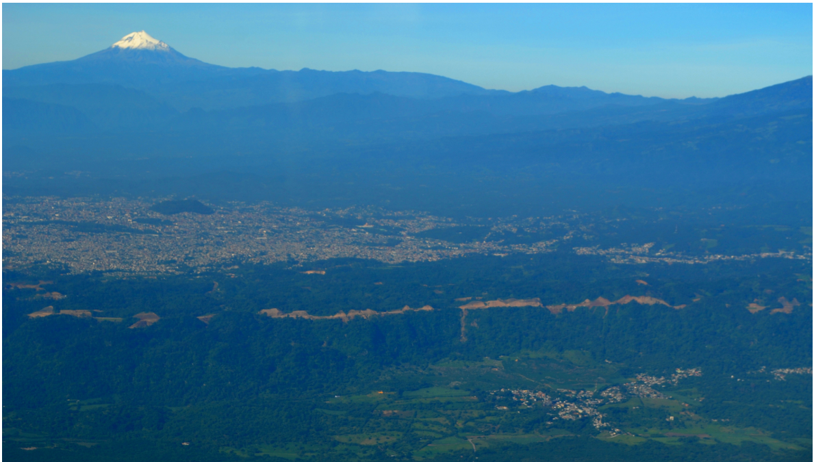
Ilustración 5.10: Panorámica de la construcción de la carretera al nor-noreste de la ciudad de Xalapa, en primer plano la localidad de "La Concha" al fondo de la "Barranca de Naolinco"
