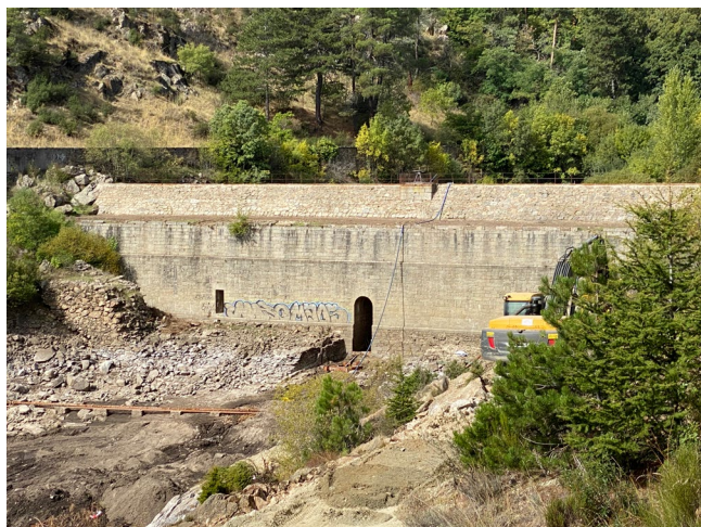
Figura 5. El vaso vacío de la presa del Romeral desde la coronación de la presa de Repullés, diciembre de 2021. Delante de la obra de Villanueva, a la izquierda, se aprecian los restos del grueso muro de mampostería del cuerpo de la presa del XVI. Fotografía: los autores.
