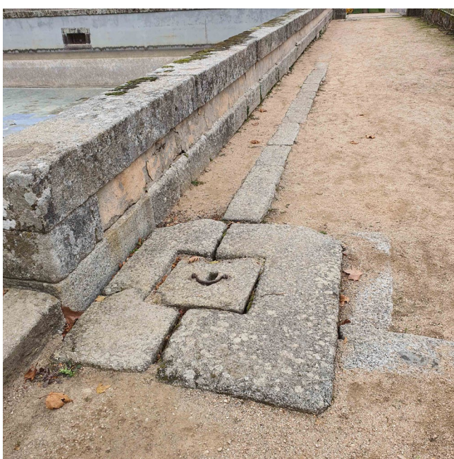
Figura 18. Jardín del Príncipe, arqueta original de granito. Fotografía los autores.
