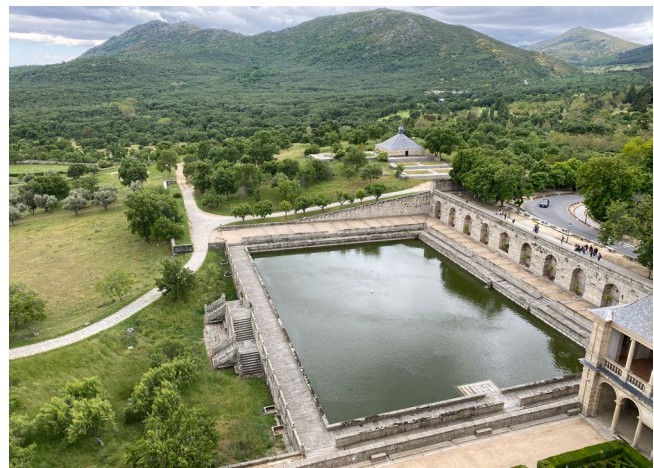
Figura 10. Vista desde la Torre de la Botica de la escalinata y el muro del Estanque grande, adosados al cual se ven las pilas de piedra y los desagüaderos, mayo de 2021. Fotografía: los autores.
