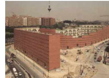
Irregularidades en el edificio
