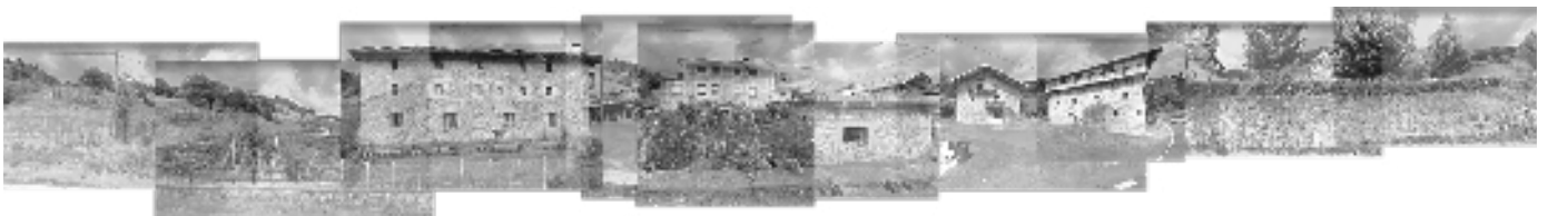
Figura 19. Alzado norte desde la carretera
