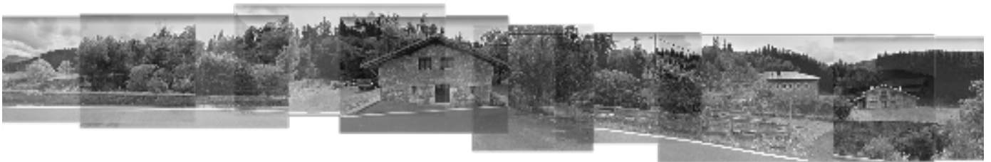
Figura 18. Alzado sur desde la carretera
