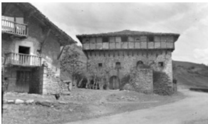
Figura 12. La Torre Aranguren junto al caserío Aranguren a su izquierda
