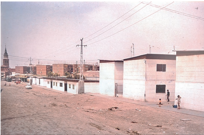
FIG.11 La UVA de Vallecas con el pueblo de Vallecas al fondo, destacando la imponente torre de la iglesia de San Pedro Ad Vincula. Fuente: ARCHIVO ASOCIACIÓN VECINAL LA UNIÓN UVA DE VALLECAS / Vallecasweb.com
