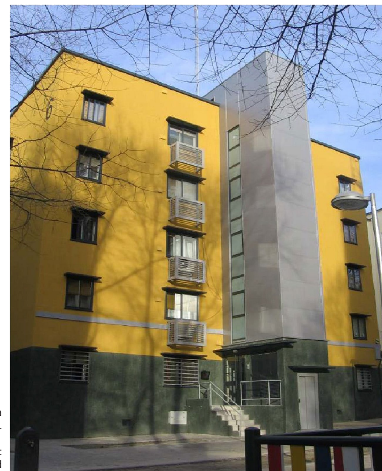
Imagen de edificio tras la rehabilitación.
