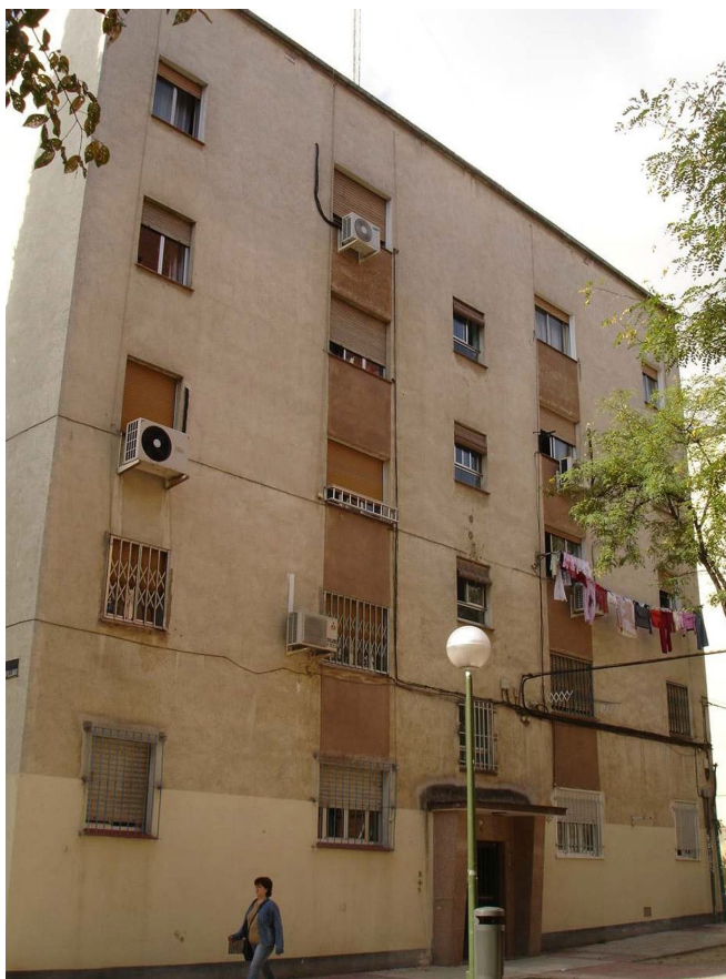
Imagen de edificio previo a la rehabilitación.
