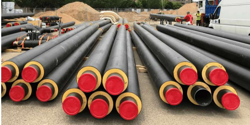
Figura 1.4 - Tuberías térmicamente aisladas.
