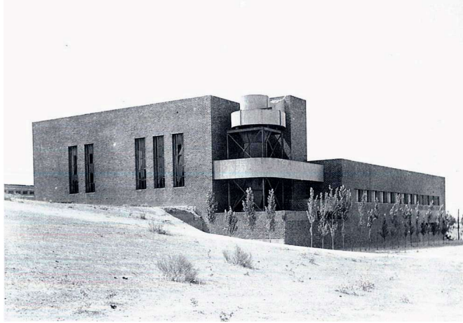
Figura 1.2 - Central térmica de Ciudad Universitaria.
