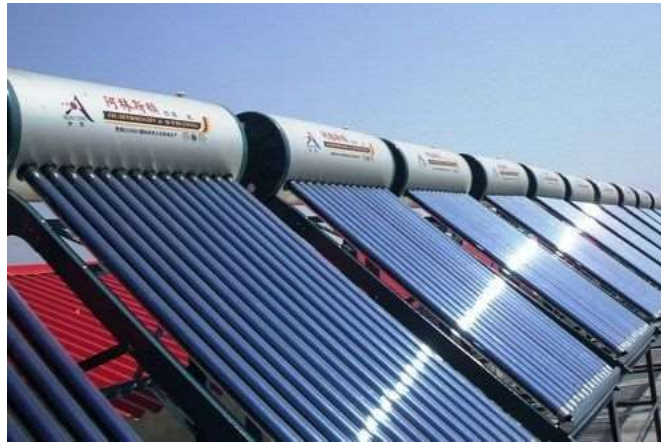
Figura 1.8 - Captador solar térmico.
