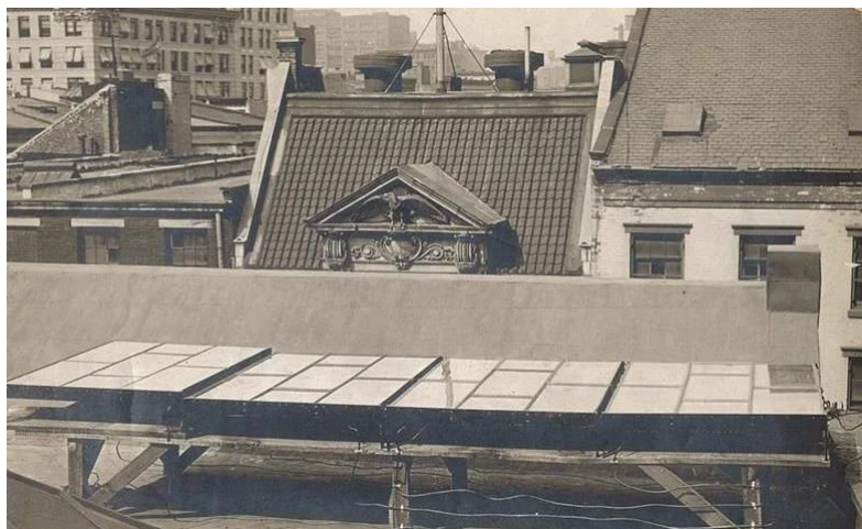
Figura 2. El primer panel fotovoltaico creado por Charles Fritts [366]
