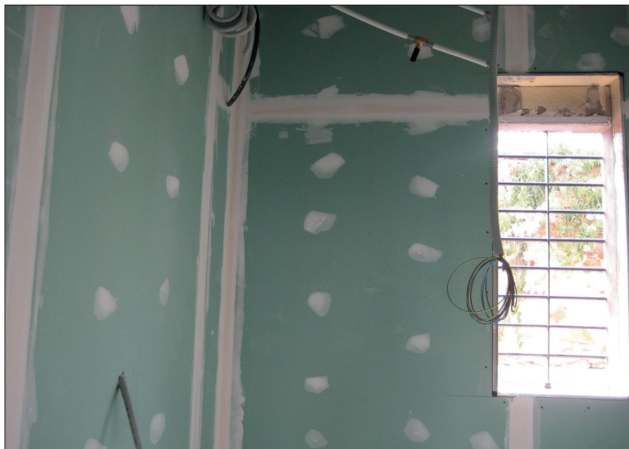
-Imagen L- Placas de yeso laminado ya colocadas en lo que será una cocina. Se procede al plastecido de las cabezas de los tornillos y a toda la longitud del encuentro de juntas.
