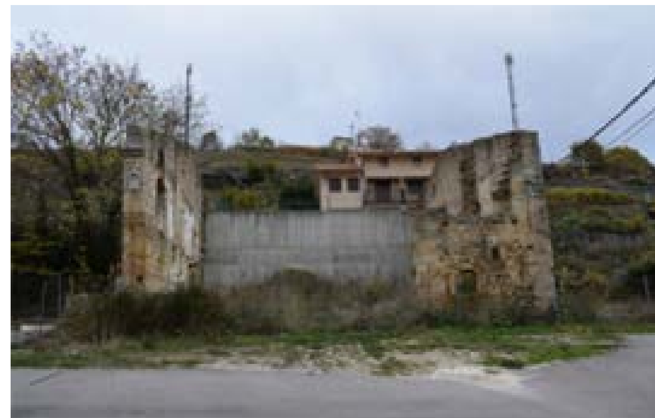
Fig.23: Fotografías del estado actual de la ruina Fuente: Elaboración propia
