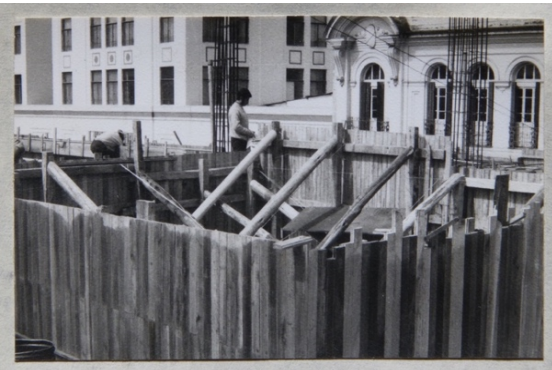
Imagen 137: Proceso constructivo del Palacio Municipal. Imágenes cortesía de Juan Espinosa
