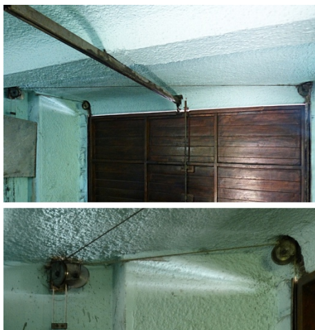
Imagen 96: Mecanismo de poleas para apertura de la puerta del estacionamiento de la Casa Kohn. Fotos: Néstor Llorca, 2016.
