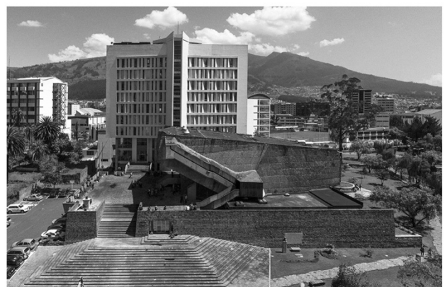
Teatro Politécnico y edificio de servicios , Volumen general © Rómulo Moya Peralta
