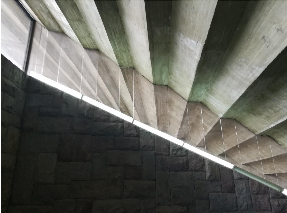
Imagen 62: Detalle del Teatro de la Escuela Politécnica Nacional. Foto: Néstor Llorca, 2017.
