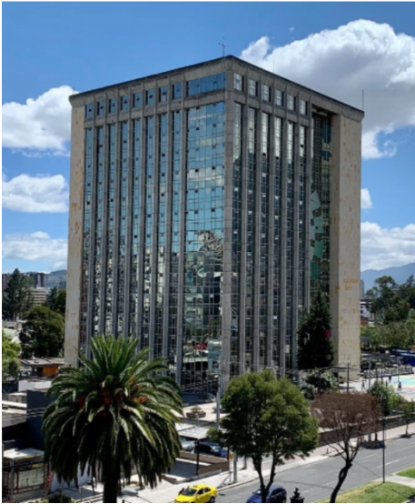
Imagen 16: "Ministerio de Agricultura, Ganadería y Pesca. Arqs. Agustín Patiño Crespo y Luis Oleas, 1979
