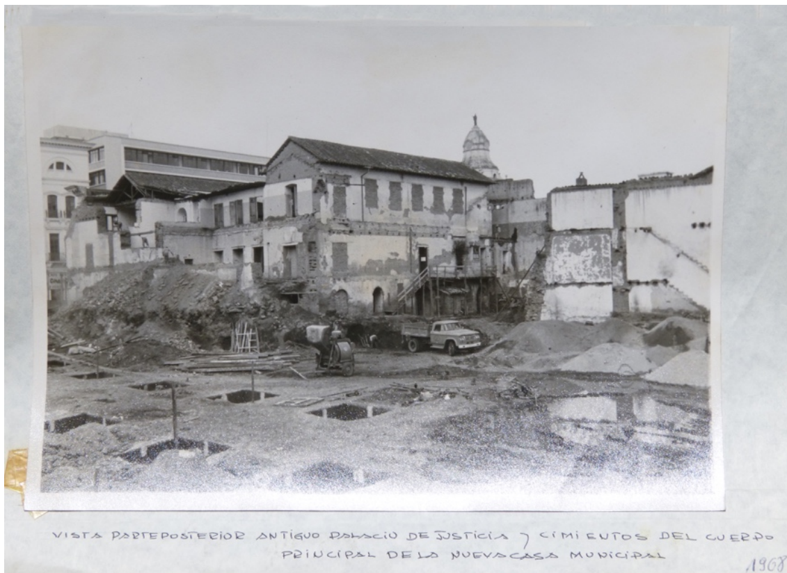
Imagen 142: Vista posterior del antiguo Palacio de Justicia y cimientos del cuerpo principal de la nueva Casa Municipal. Imagen cortesía de Juan Espinosa.
