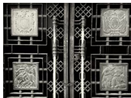
Imagen 47: Detalle edificio Arq. Hopkins y Dentz, 1936, foto Paco Salazar, 2013.
