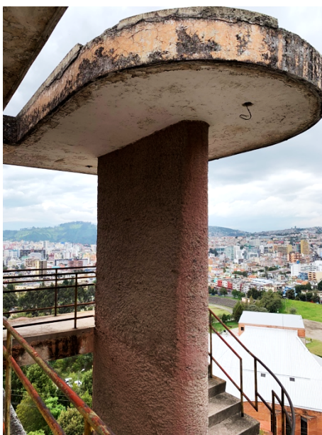
Imagen 84: Detalle de escalera exterior de la Residencia Estudiantil de la UCE. Foto: C. Luna, 2019.
