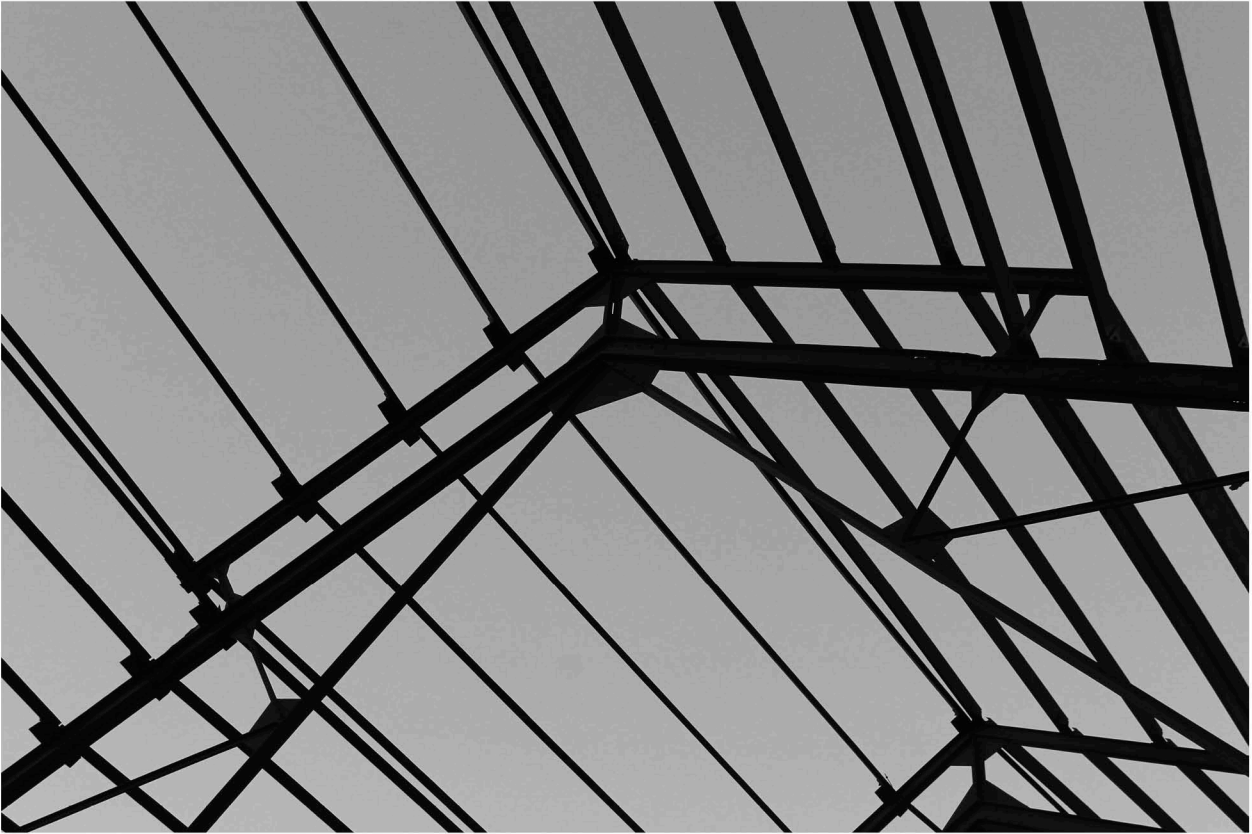
Vista de la estructura de la cubierta de la rotonda de Horna-Villarcayo, 2021
