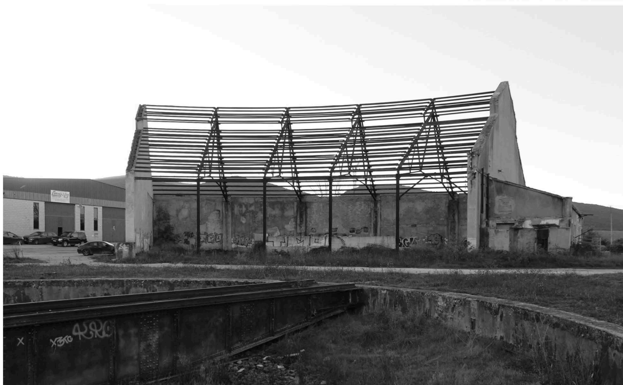
Estado actual de la rotonda de Horna-Villarcayo, 2021
