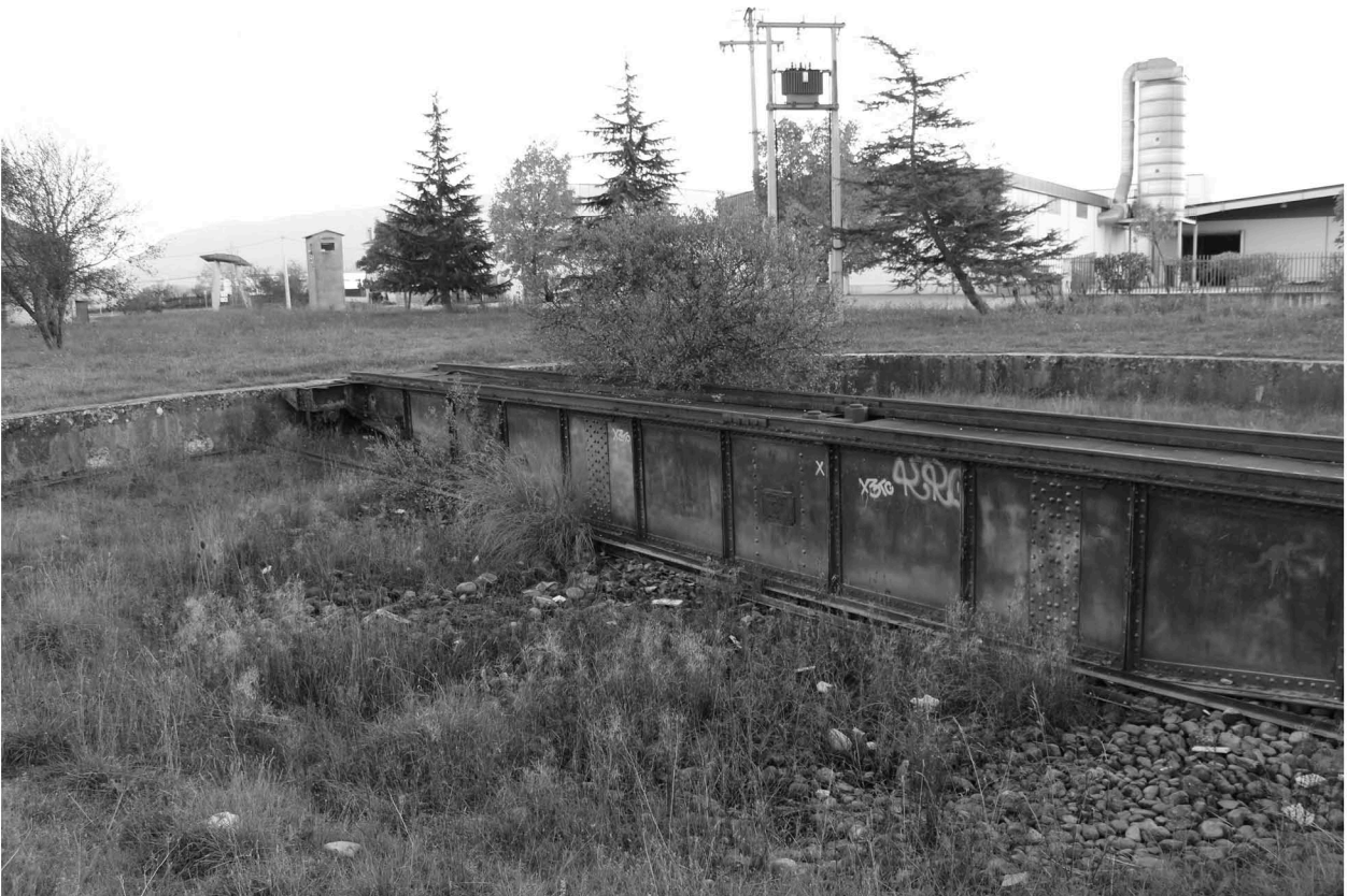
Estado actual del puente giratorio de Horna-Villarcayo, 2021
