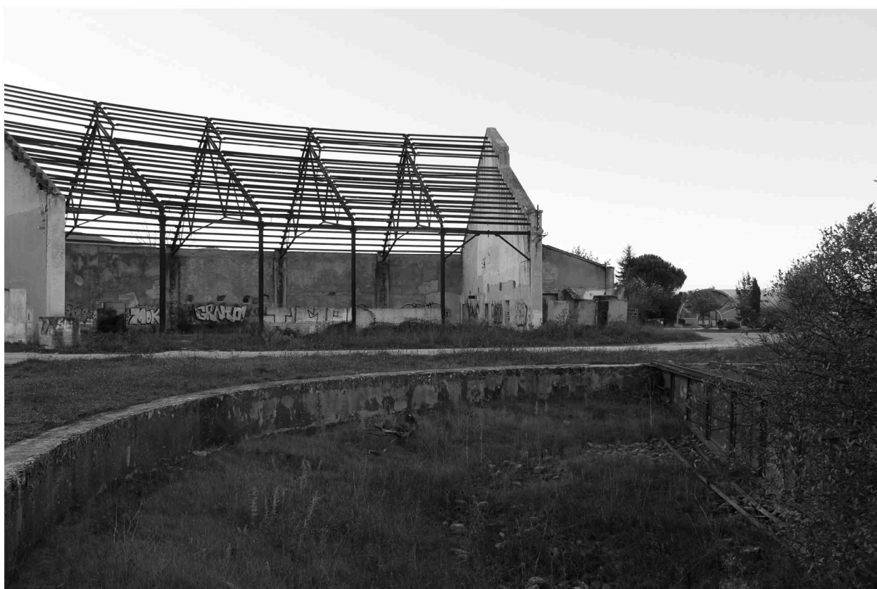
Estado actual del puente giratorio y rotonda de la estación de Horna-Villarcayo, 2021
