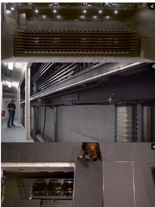
Figura 5. Tres instantes del proceso de ocultamiento de la tribuna retráctil. www.figueras.com
