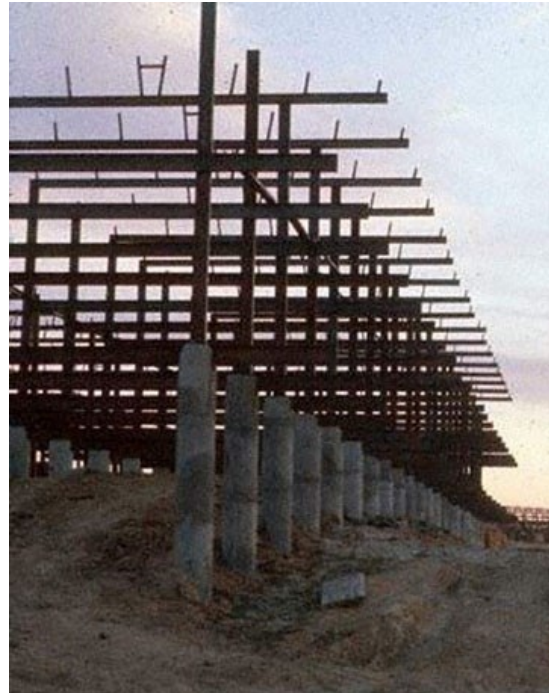
Fotografía de la construcción de la estructura metálica
