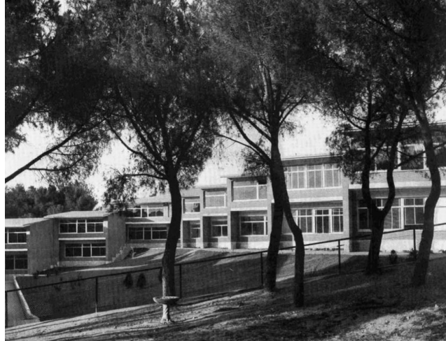
Figura 27. Vista del Colegio San Luis de los Franceses. Fuente: informe de la construcción
