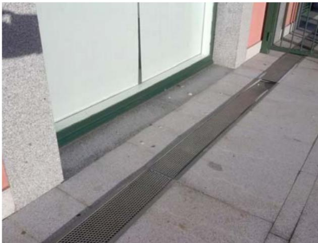
*Foto 1 – Sumidero lineal en cubierta plana transitable con solado de granito*
