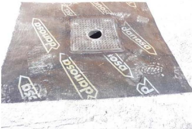
*Foto J – Vista de la colocación de una cazoleta de EPDM y de la lámina de refuerzo previa a la lámina general*
