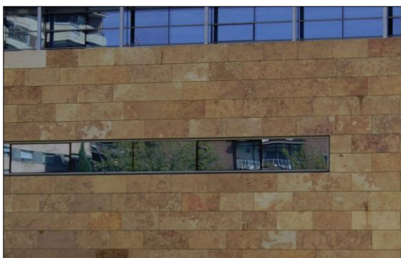
Fig. 2: Fachada ventilada con baldosas de piedra natural
