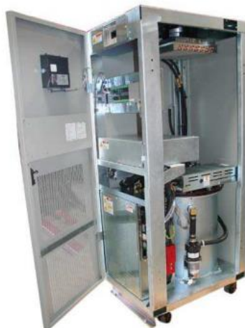
Figura 2.17. Sistema de almacenamiento con volante de inercia [40].
