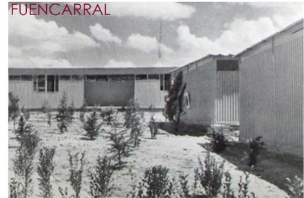
Se realizaron 1180 viviendas en 13 hectáreas. Se realizó con un sistema constructivo de prefabricación.
