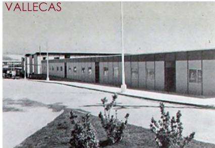
Se realizaron 1.200 viviendas en 12 hectáreas. Con un presupuesto de 164 millones de pesetas. Se realizó con un sistema constructivo de prefabricación.
