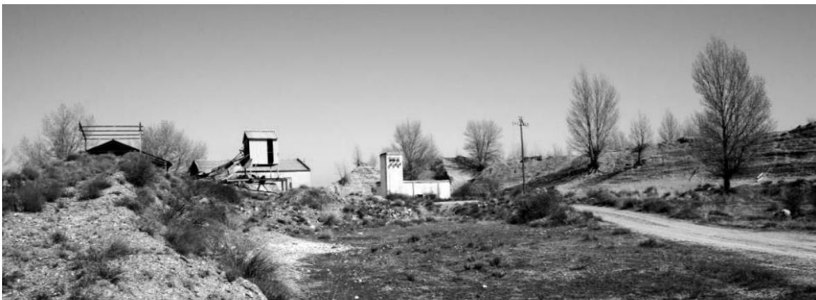
Figura 6: Las instalaciones de relavado de lodos abandonadas cerca de las balsas (Regidor Ipiña et al., 2010).
