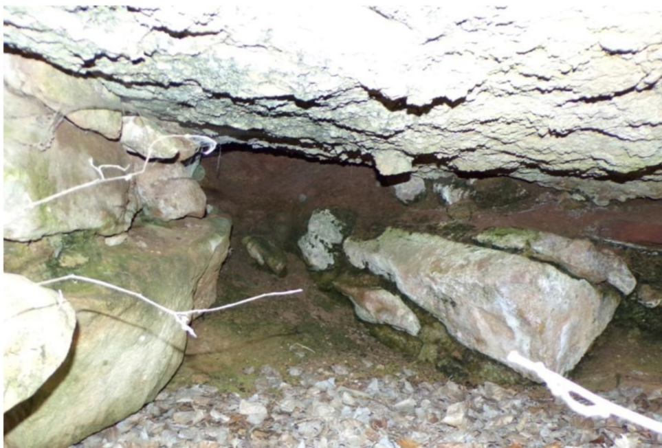
Fig.12.- Imagen del interior del dolmen. Existe una capa superficial de material orgánica vegetal. El estado es ruinoso desde hace tiempo, y las paredes de tierra están consolidadas. Es posible que su conservación se deba a que se reutilizara, para las laboras hortícolas descritas anteriormente.
