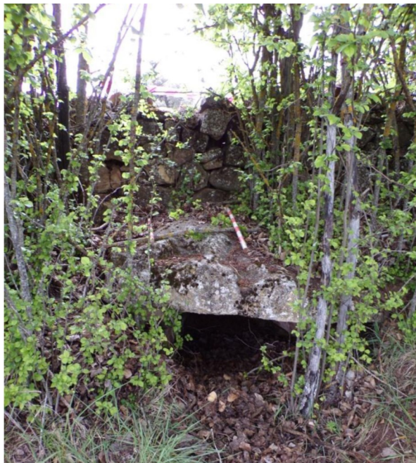
Fig. 10.- Otra vista de la zona de entrada. Cuando se perdió la funcionalidad hortícola quedó abandonada y cubierta de vegetación que ha servido para protegerlo. En el terreno adyacente también se documenta un sistema de canalización y regadío obsoleto y colmatado.
