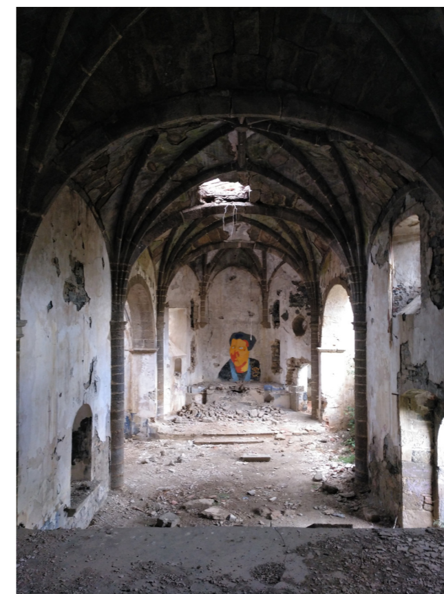
Fig. 58. Vista del interior de la iglesia desde arriba de las escalas, Fotografía del autor.
