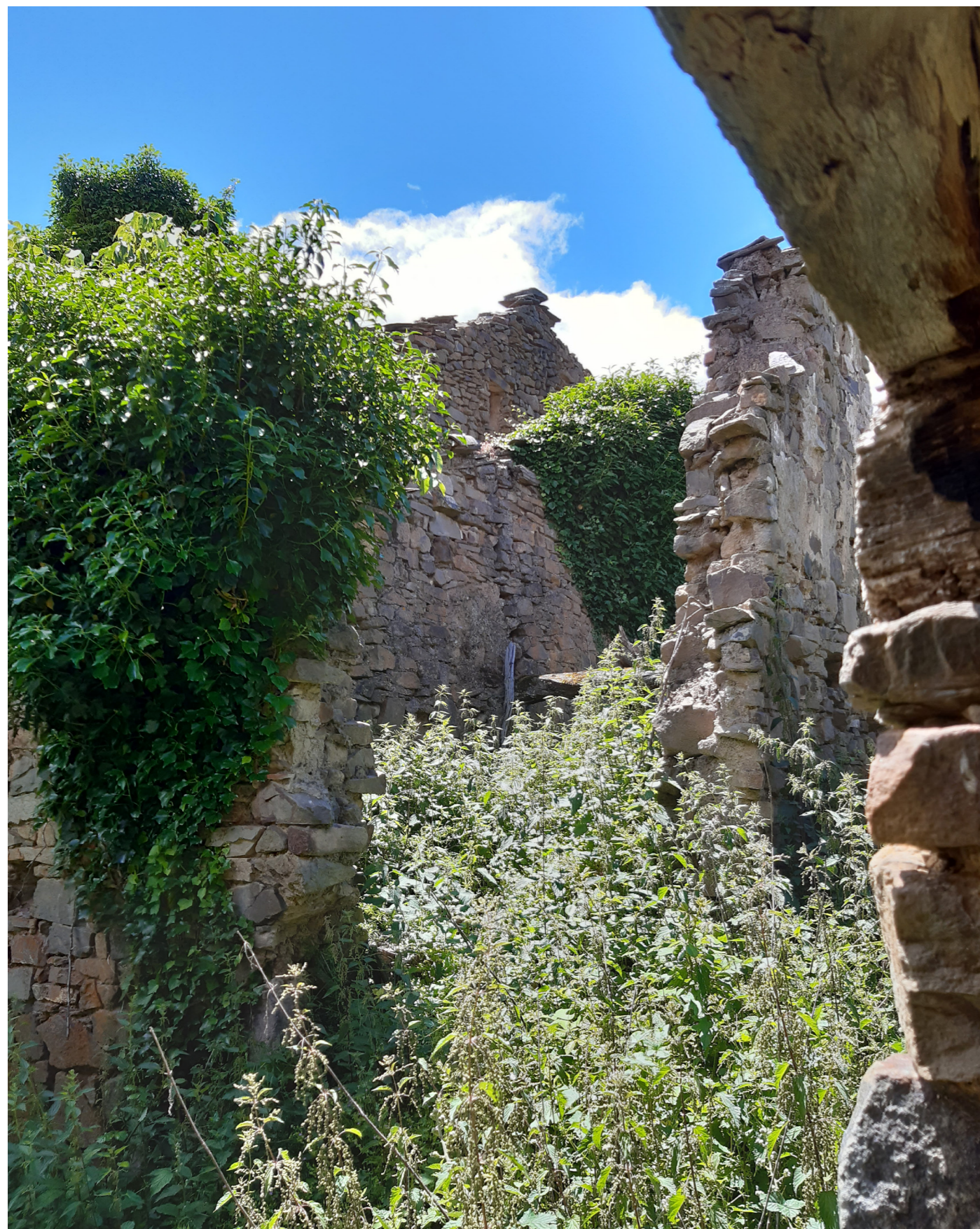
Fig. 106. Vista desde debajo del cargadero de una puerta de acceso a una vivienda del poblado. Fotografía del autor.
