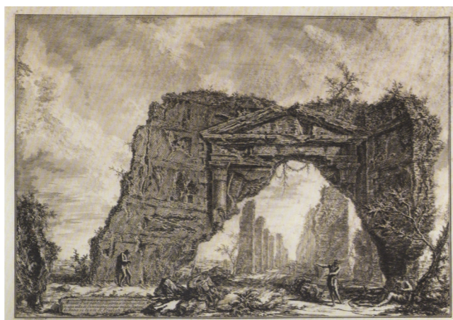
Fig. 7. Restos de un pórtico cubierto, o criptopórtico, de una villa de Domiziano, a cinco millas de Roma, en la vía de Frascati. Grabado de Piranesi. (Butí et al., 2005)
