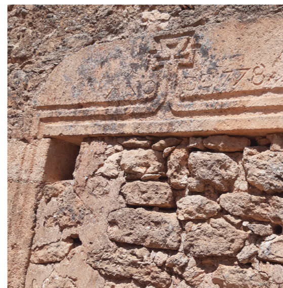
Fig. 88. Dintel de la puerta de una vivienda. Fotografía del autor.
