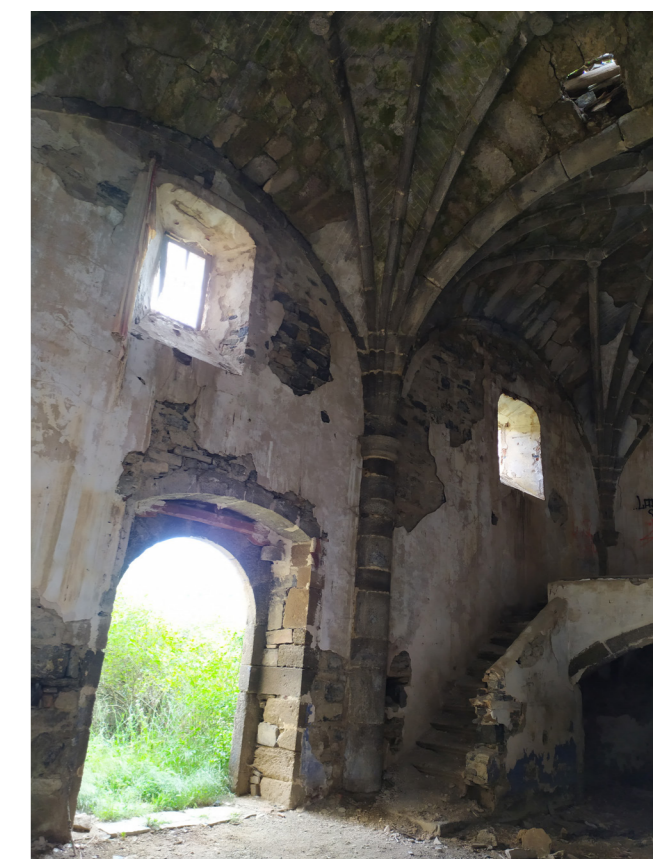
Fig. 56. Puerta de acceso a la iglesia. Fotografía del autor.
