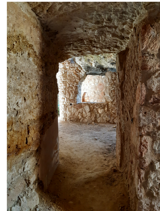
Fig. 70. Hueco de paso entre galerías subterráneas. Fotografía del autor.
