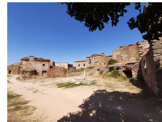
Fig. 73. Panorámica de la plaza del pílón. Fotografía del autor.
