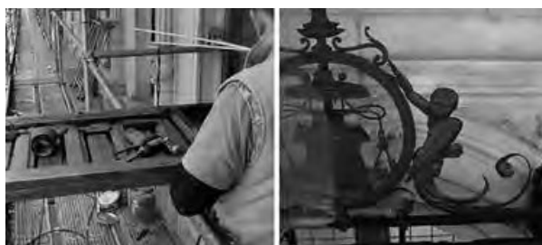
Figura 6. Izquierda Trabajos en carpinterías. Derecha: Trabajos sobre Rejas. Diferentes fases. Fuente: Autores.
