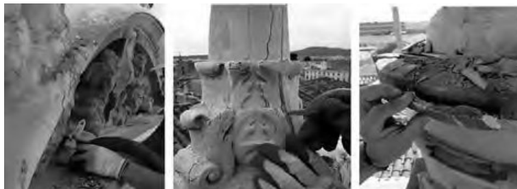
Figura 2. Izquierda Procesos realizados en la Fase I, de limpieza en seco. Izquierda: Aspiración. Centro: Retirada con bisturí. Derecha: Retirada de piezas sueltas. Fuente: Autores.
