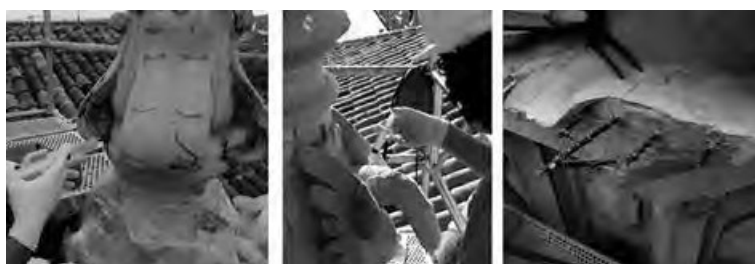
Figura 4. Izquierda Procesos realizados en la Fase IV, de reintegración de piezas dañadas. Izquierda y centro: Relleno de fisuras con inyecciones epoxi.
