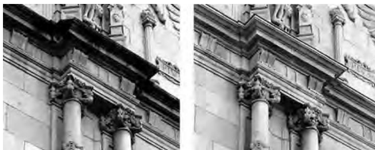
Figura 8. Detalle de cornisa planta primera. Izquierda antes. Derecha después. Fuente: Autores.
