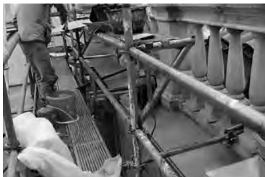
Figura 5. Trabajos para la disposición de protecciones de Zinc. Fuente: Autores.
