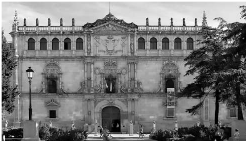
Figura 1. Imagen de la fachada previa a la intervención. Fuente: Autores.
