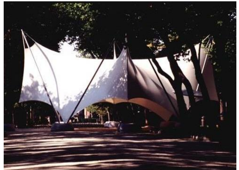
Imagen 9. Cubierta Starwave para la “la Biennale di Venezia 1996”, Frei Otto, SL Rasch. Estructura móvil para exposición con cimentación temporal mediante contrapesos. (Rasch Archivos)
