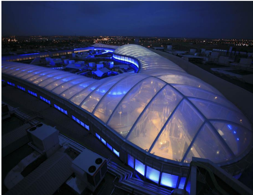
Imagen 67. Cubierta de los Malls y Plaza Caraba del C.C. Isla azul. Madrid. España, L35 Arquitectos. Cojines de doble lámina de ETFE de 250 \mu\text{m} impresa / 250 \mu\text{m} transparente ( https://www.iasoglobal.com/docs/IASO_ETFE_2014_ES.pdf )
