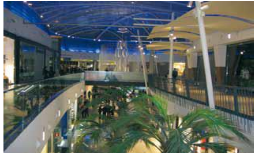
Imagen 69. Cubierta de los Malls y Plaza Caraba del C.C. Isla azul. Madrid. España, L35 Arquitectos. Cojines de doble lámina de ETFE de 250 \mu\text{m} impresa / 250 \mu\text{m} transparente ( https://www.iasoglobal.com/docs/IASO_ETFE_2014_ES.pdf )
