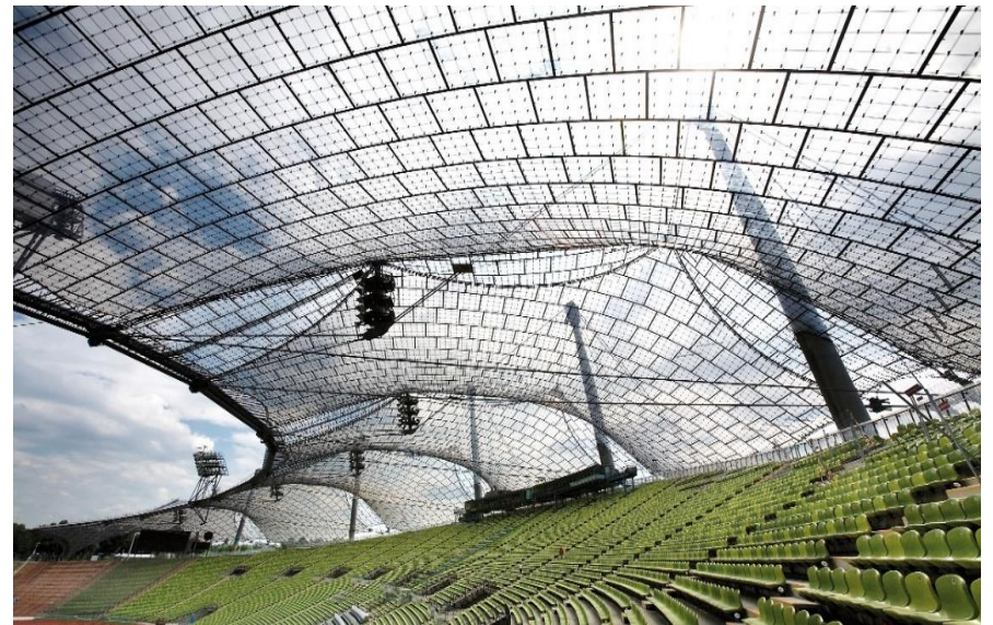
Imagen 8. Tensed structures, Parque Olímpico de Múnich, de Frei Otto y Günter Behnisch (1972) (imagen obtenida de: https://revistalibero.com/blogs/contenidos/lapiel-de-serpiente-del-olimpico-de-munich )
