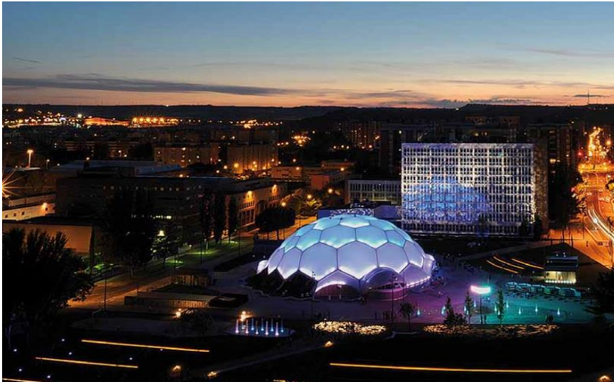
Imagen 26. Cúpula de la plaza del Milenio, Valladolid. España, Enric Ruiz-Geli CLOUD9, 2.200 m 2 Cojines de triple capa. IASO "ETFE, La Arquitectura Transparente" ( https://www.iasoglobal.com/docs/IASO_ETFE_2014_ES.pdf )
