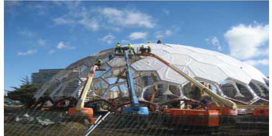
Imagen 24. Cúpula de la plaza del Milenio, Valladolid. España, Enric Ruiz-Geli CLOUD9, 2.200 m2 Cojines de triple capa. IASO “ETFE, La Arquitectura Transparente” ( https://www.iasoglobal.com/docs/IASO_ETFE_2014_ES.pdf )
