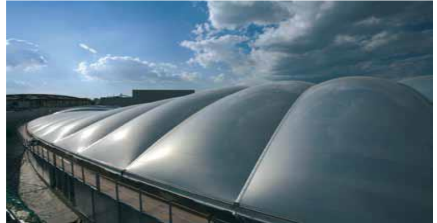
Imagen 68. Cubierta de los Malls y Plaza Caraba del C.C. Isla azul. Madrid. España, L35 Arquitectos. Cojines de doble lámina de ETFE de 250 \mu\text{m} impresa / 250 \mu\text{m} transparente ( https://www.iasoglobal.com/docs/IASO_ETFE_2014_ES.pdf )
