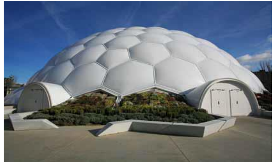
Imagen 25. Cúpula de la plaza del Milenio, Valladolid. España, Enric Ruiz-Geli CLOUD9, 2.200 m2 Cojines de triple capa. IASO “ETFE, La Arquitectura Transparente” ( https://www.iasoglobal.com/docs/IASO_ETFE_2014_ES.pdf )
