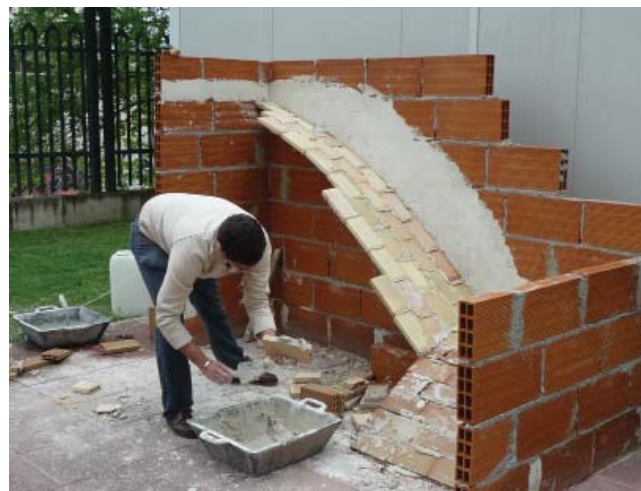
Figura 6. Proceso de ejecución de la primera rosca del segundo tramo de una escalera tabicada (III). Curso 2011-12.
