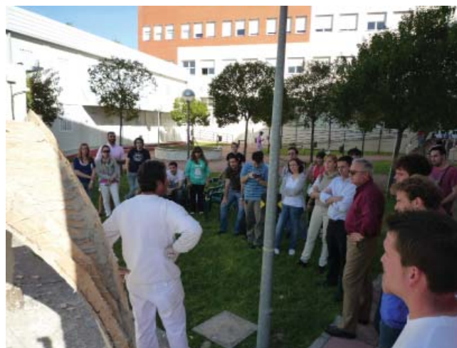
Figura 9. Clausura de las Jornadas tras la realización de una bóveda de arista encamonada.
