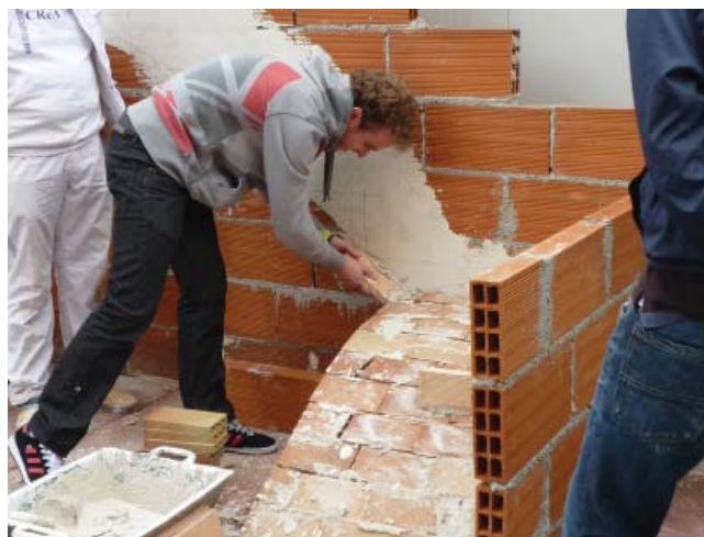
Figura 4. Proceso de ejecución de la primera rosca del segundo tramo de una escalera tabicada (I). Curso 2011-12.
