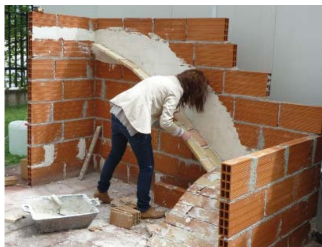
Figura 5. Proceso de ejecución de la primera rosca del segundo tramo de una escalera tabicada (II). Curso 2011-12.
