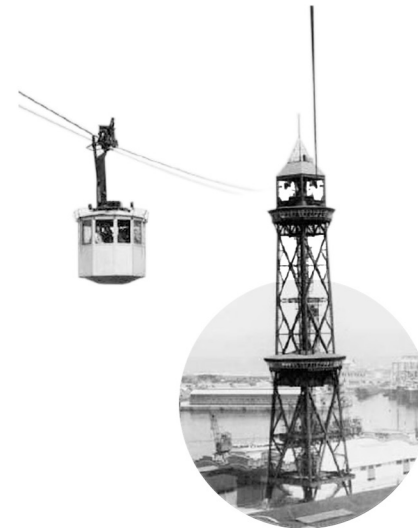
TORRE DE JAUME I CARLES BUÏGAS 1931 UBICACIÓN: Barcelona, España FUNCIÓN: Intercambiador teleférico, h = 107 m CONSTRUCCIÓN: Acero
