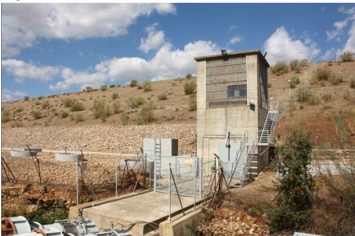
Figura 22. Imagen del puesto de control de las válvulas de desagüe de la presa de El Pardo. Fuente: Google Earth
