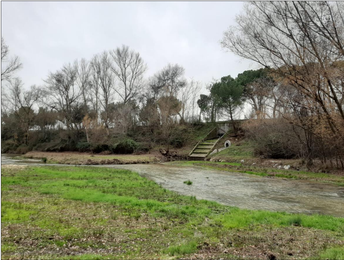
Figura 28. Fotografía del tramo del frezadero. Perspectiva amplia en la que se observa una acumulación de sedimentos en la parte izquierda, bien sujetos por vegetación. Son sedimentos consecuencia de la Playa de Madrid. Fuente: Realización propia.
