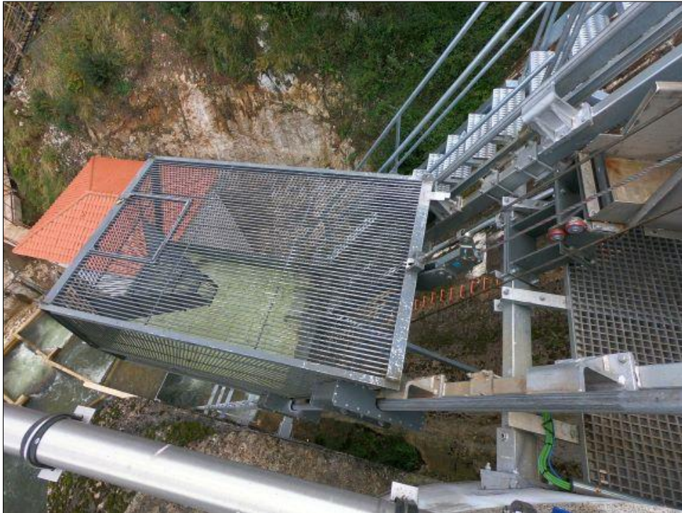
Figura 16. Fotografía de ascensor para peces de la presa de Palombera (Cantabria). Fuente: https://blogs.20minutos.es/cronicaverde/2021/01/09/inauguran-en-cantabria-el-primer-ascensor-espanol-para-salmones/
