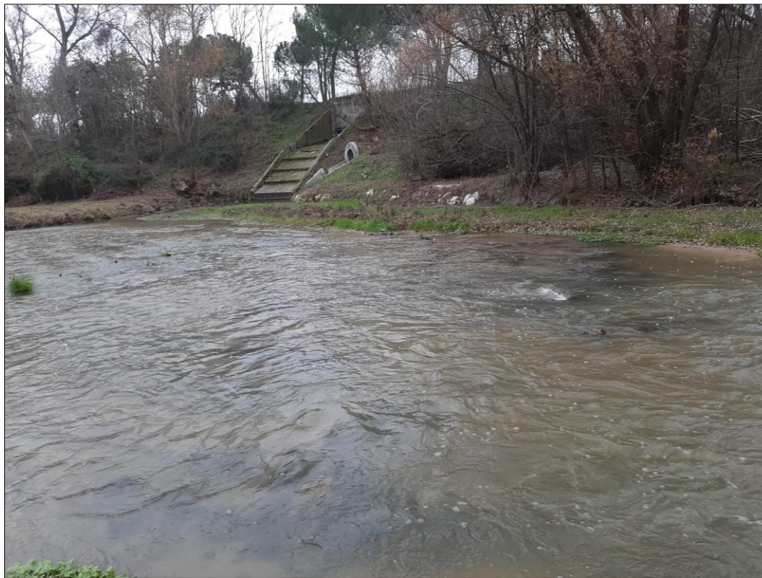
Figura 26. Fotografía del tramo del frezadero. Se observa una canalización que vierte agua de dudoso contenido en el cauce. Ha de ser sellada y redirigida. Fuente: Realización propia.
