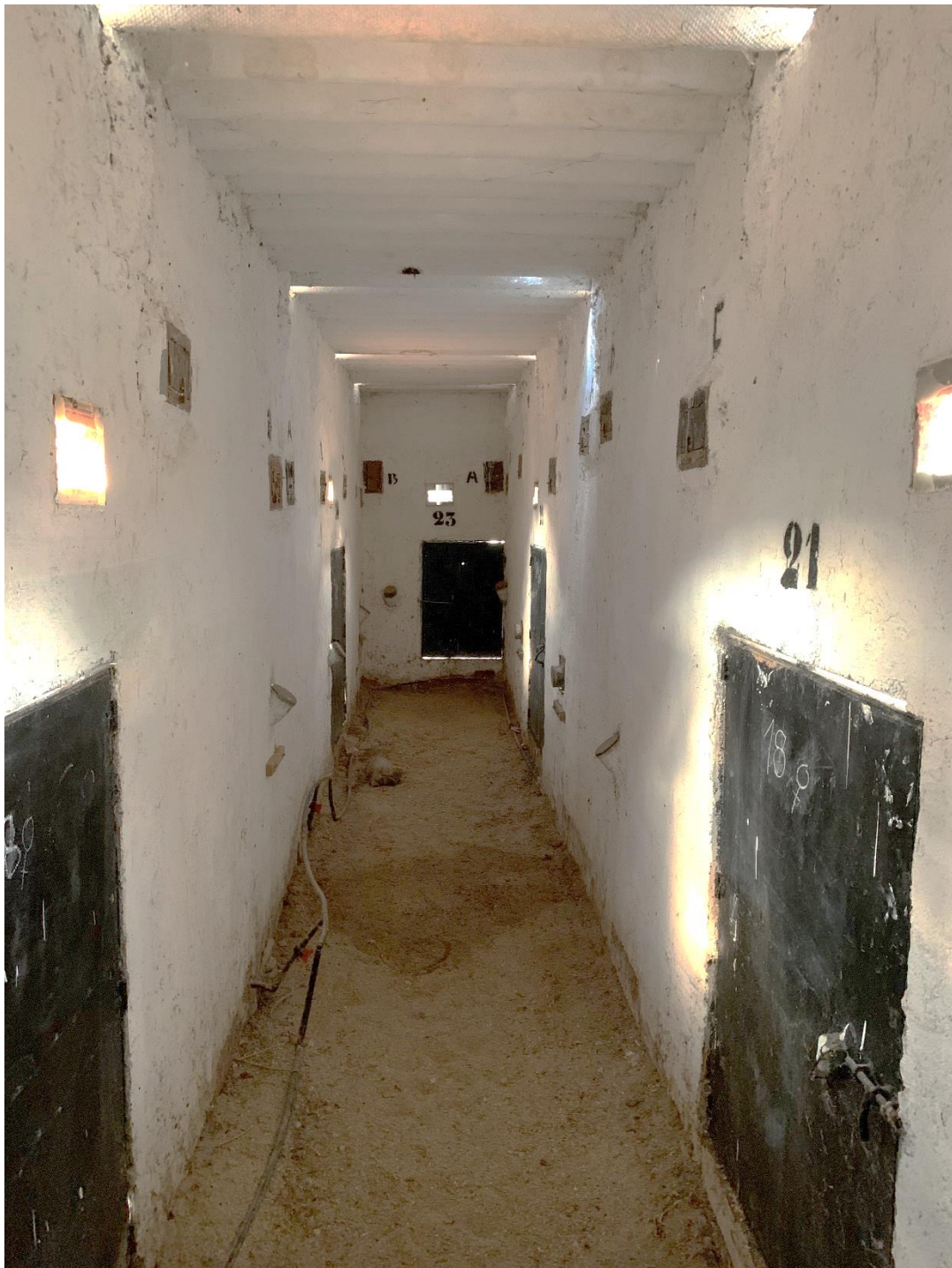
Figura 4: Ejemplo de pasillo para acceder a las instalaciones. De arriba abajo, pueden observarse los accesos a los nidos para el control de las puestas, las ventanas con cristales espía, los tubos para el aporte de alimento desde el exterior, las puertas de acceso y las tuberías para el aporte de agua. Fuente: Propia
