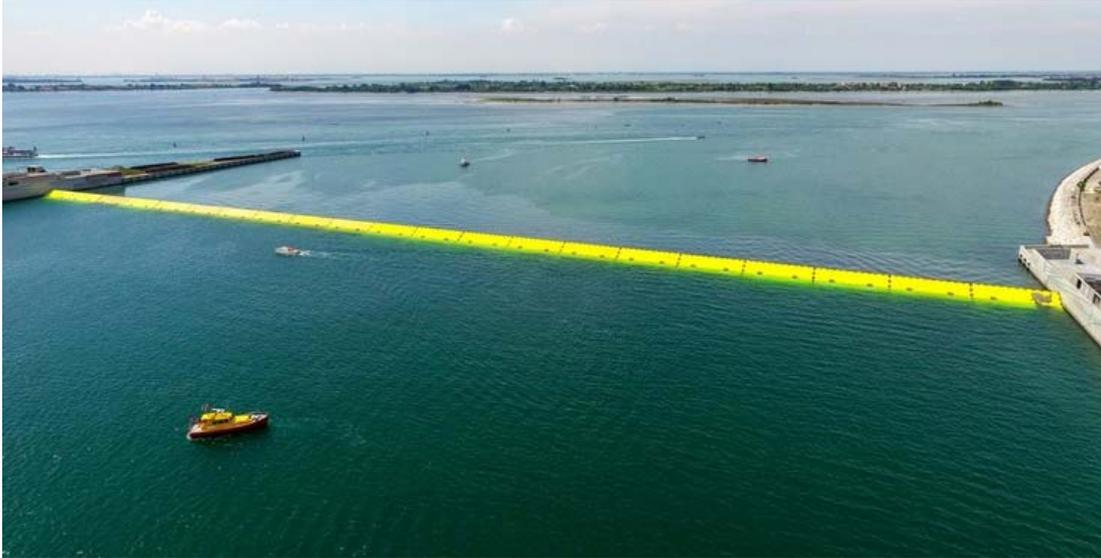
*Ilustración 57: Compuerta del MOSE cerrada. Fuente: buildingcue (2019)*
