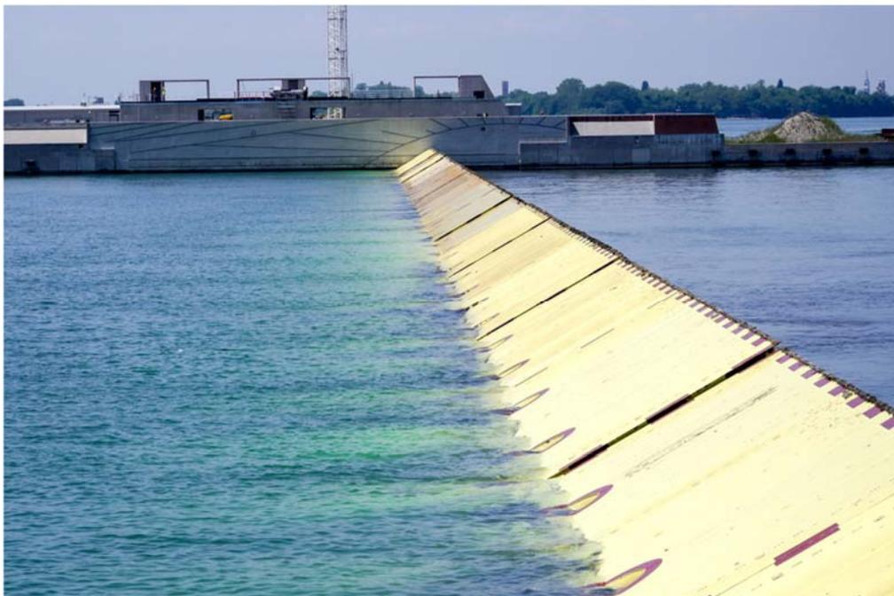
Ilustración 33: Prueba de levantamiento de las compuertas en el dique norte del Lido el 26 de mayo de 2016. Consorzio Venezia Nuova (2017)
