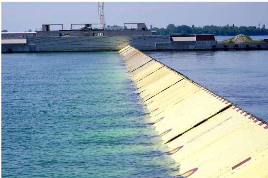
*Ilustración 52: Prueba de funcionamiento de una barrera del MOSE en mayo de 2016*
