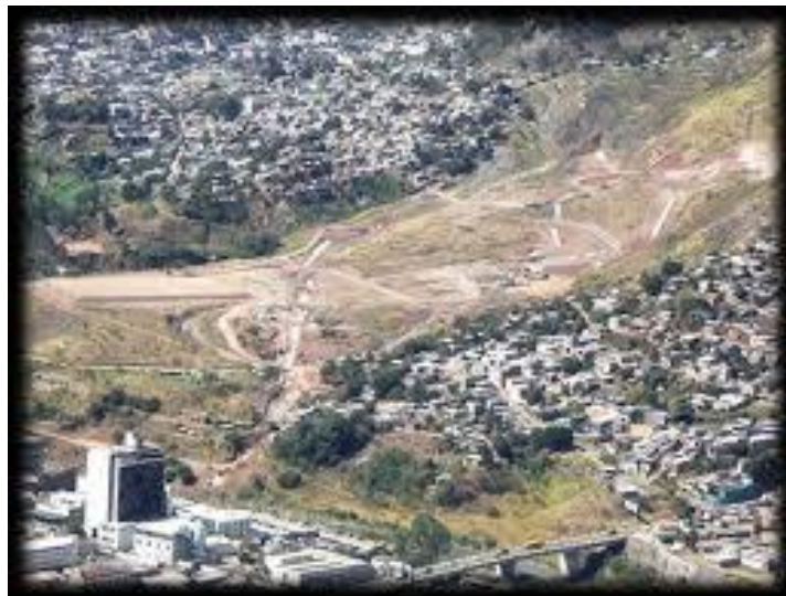
Figura 27. Fotografía de Cerro El Berrinche con la obra ejecutada.
