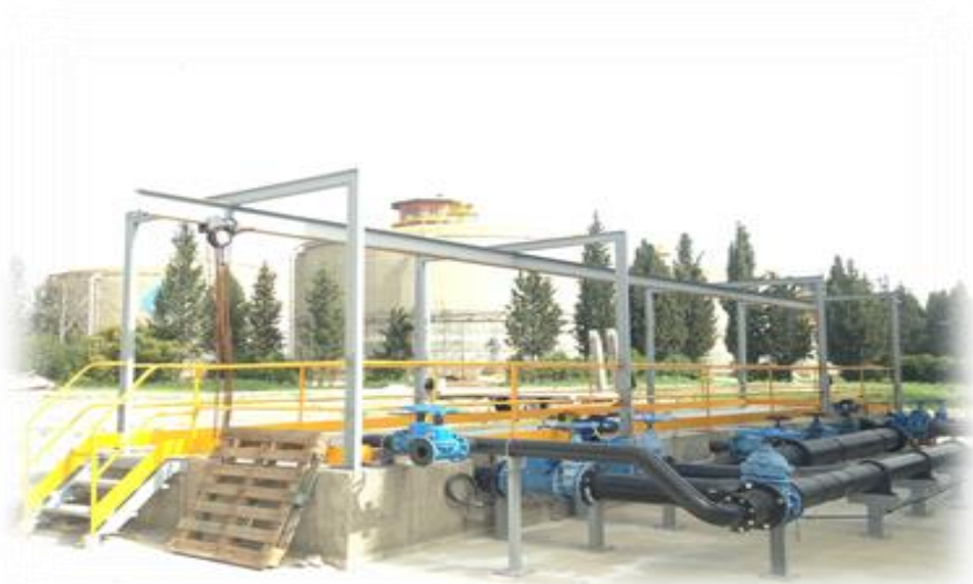
Figura 9. Electrobombas sumergibles y depósitos. Fuente: Elaboración propia.
