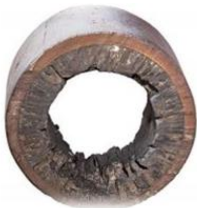
Figura 2. Precipitación de estruvita en conducción. Fuente: web hrs-heatechangers.com
