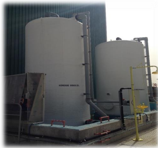
Figura 10. Depósitos de NaOH y \text{MgCl}_2 . Fuente: Elaboración propia.
