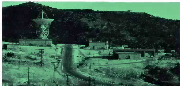
Figure 1. Instalación Apolo de Madrid
