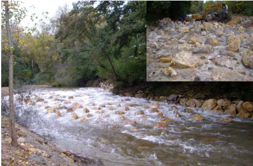
Figura 31. Fotografía de la disposición de los bolos de piedra en el río Najerilla, La Rioja. (Fuente: Sanz-Ronda et al., 2012)
