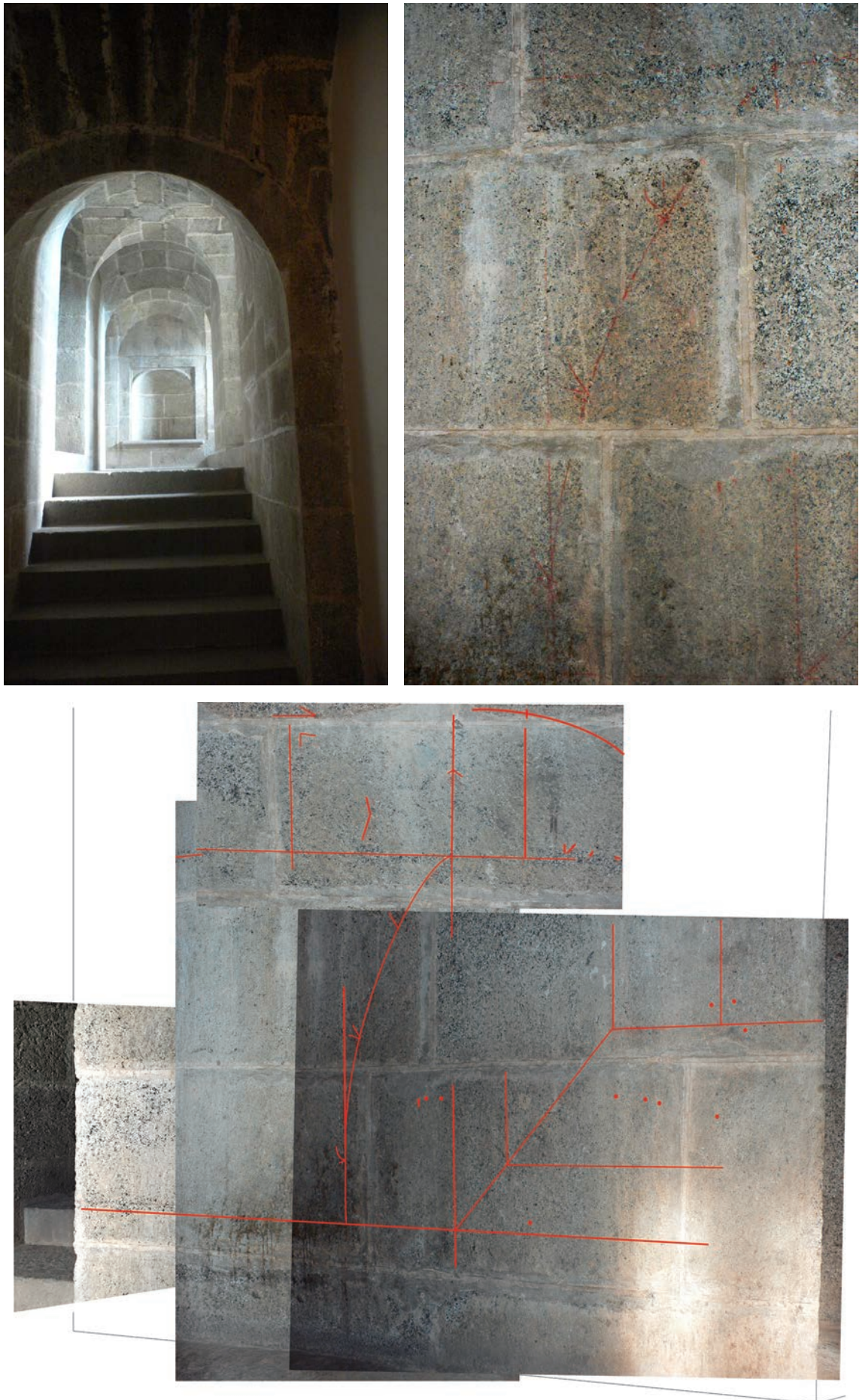
Figura 7. Monteas en los sótanos de Platerías. Bóvedas, detalle y restitución de las monteas conservadas en el lienzo norte.
