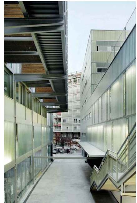
Fig. 8. Jaime Coll y Judith leclerc. Edificio de equipamientos en Londres/Villaroel. Barcelona. Fotografía, viviendas a la izquierda, centro escolar a la derecha
