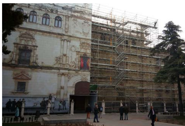
Figura 2: Disposición de lona decorativa sobre el andamiaje. Imagen del montaje de la lona. Fuente Elaboración propia.
