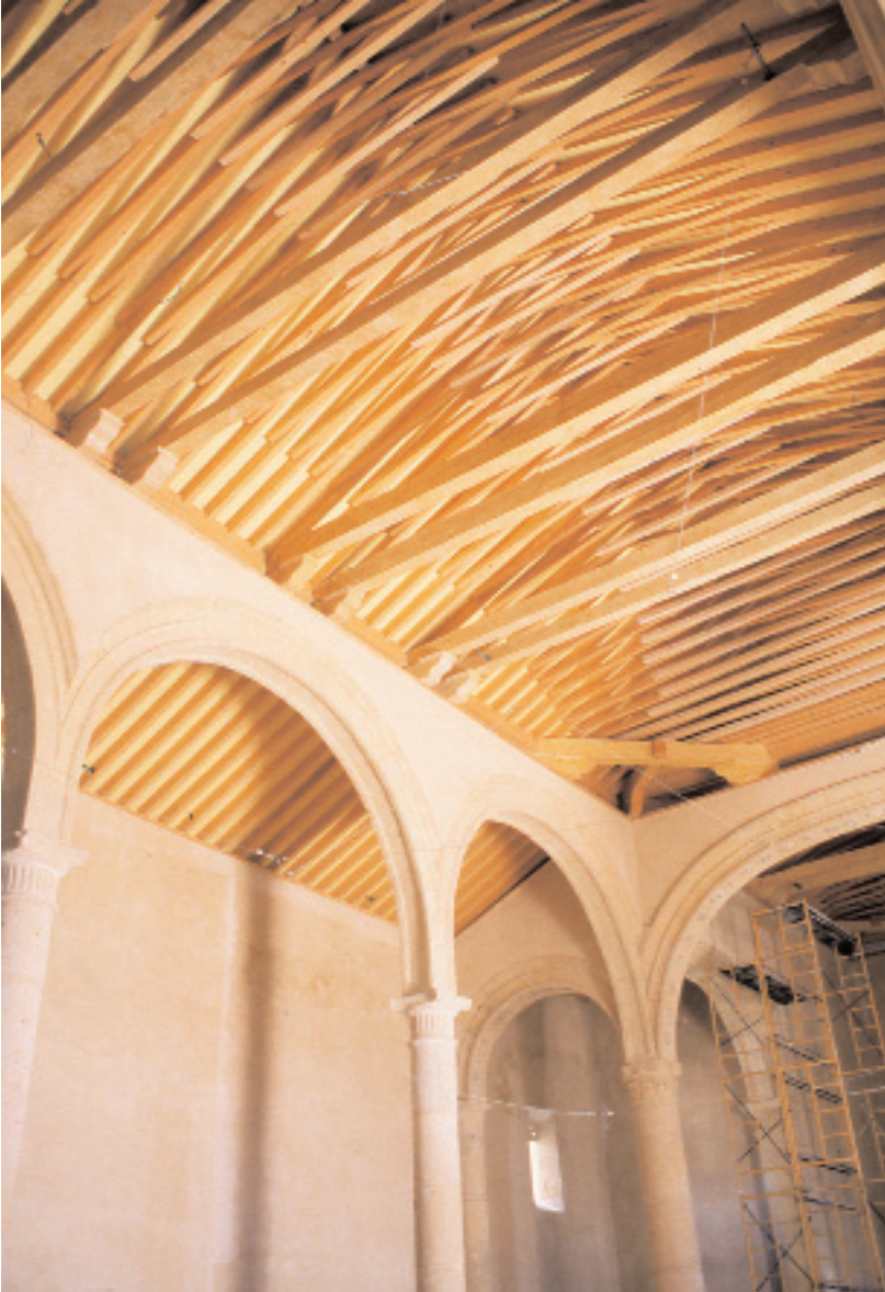
Nuevo artesanado de madera como estructura de soporte de la cubierta de la iglesia de Valdetorres de Jarama en Madrid. Foto: Latorre y Cámara arquitectos
