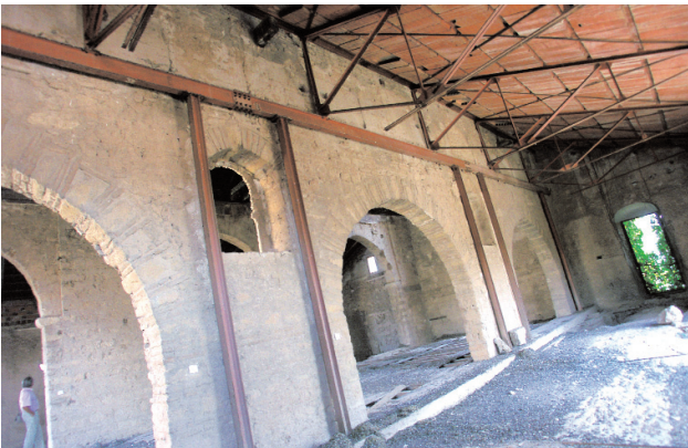
Antigua consolidación estructural de la cubierta de la iglesia del convento de Santa Clara en Córdoba mediante la superposición de una estructura de acero apoyada en zunchos y forjados de hormigón. Foto: Pablo Latorre González-Moro
