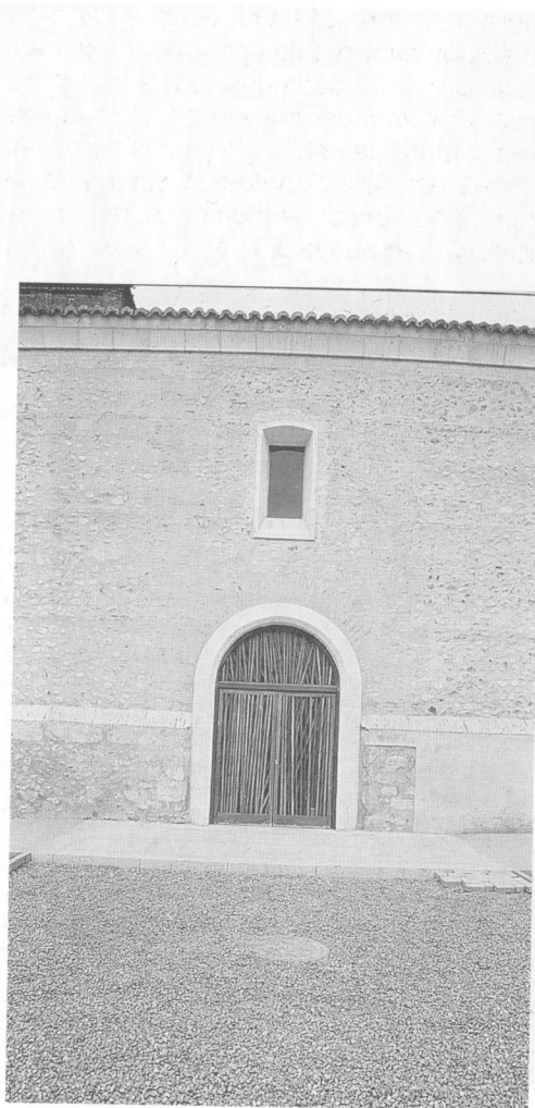
Tramo central de la fachada sur restaurada, con los revestimientos y trabajos de cantería. Foto: LyC.
