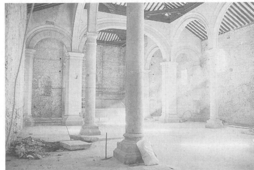
El interior de la iglesia una vez levantados los revestimientos de cemento de sus paños alzados. Foto: LyC.
