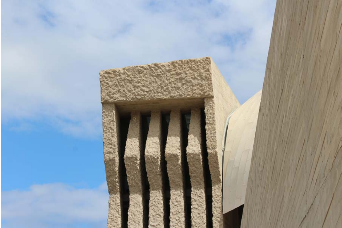
figura22_detalle de la fachada del edificio. Las grietas en los módulos pétreos permiten la entrada de la luz y el aire en el edificio Fotografía de la autora, 2016
