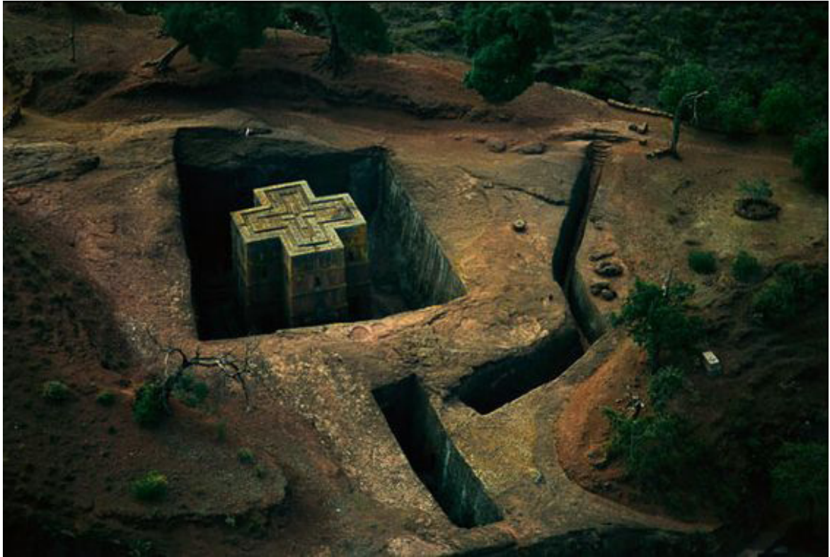
figura5_ Fotografía aérea de la iglesia Bieta Abba, excavada en la roca. Lalibela, Etiopía.
