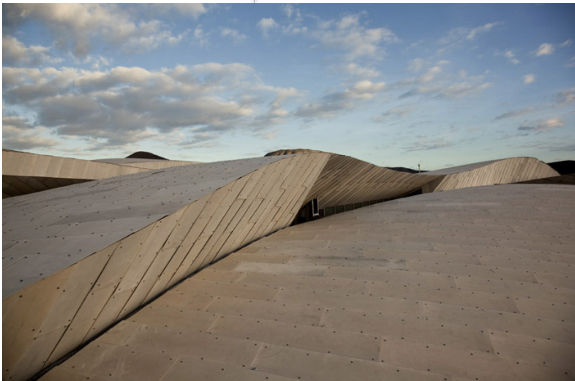
figura20_fotografía de la cubierta con acabado de fibrocemento Fotografía de Simona Rota, 2012
