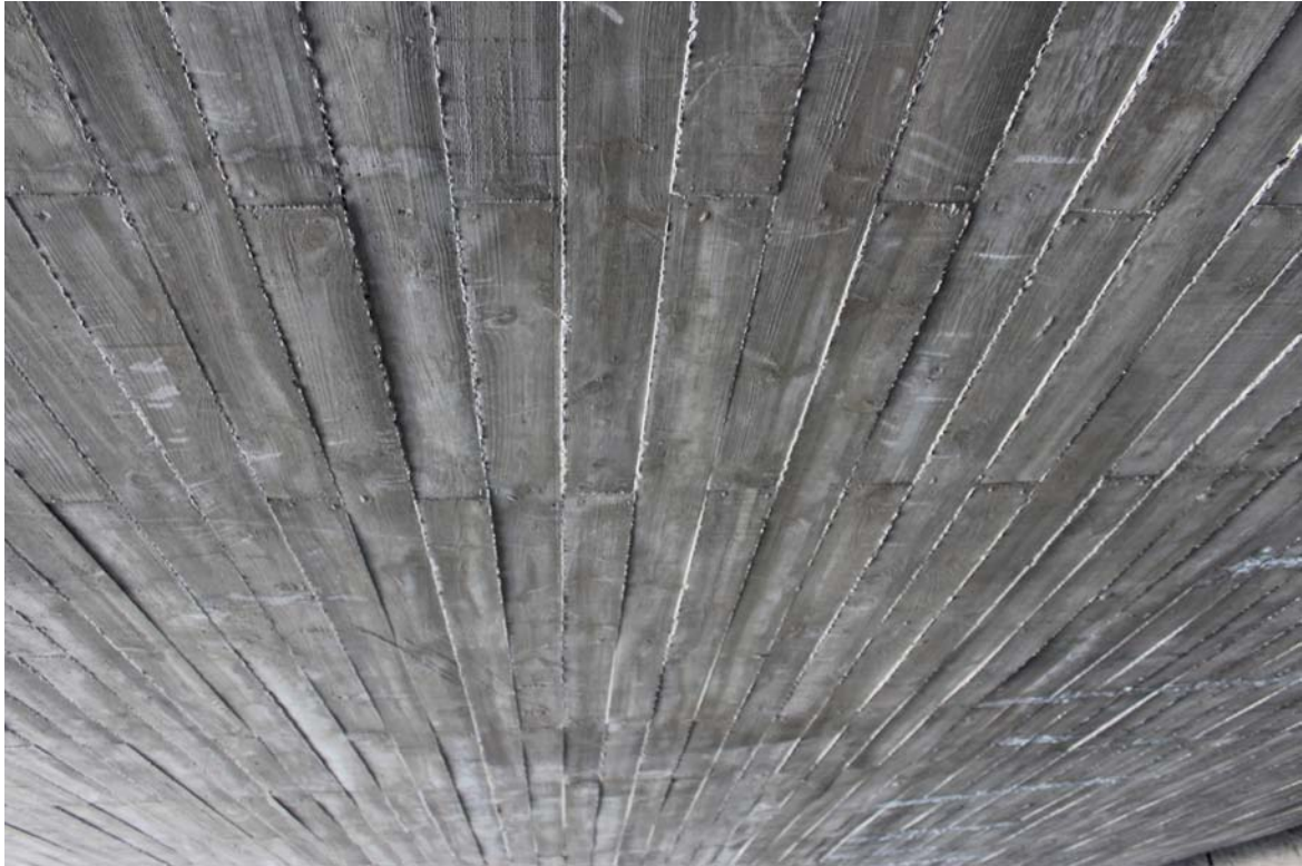
figura11_textura del hormigón en el techo del vestíbulo: encofrado con tablas de madera
