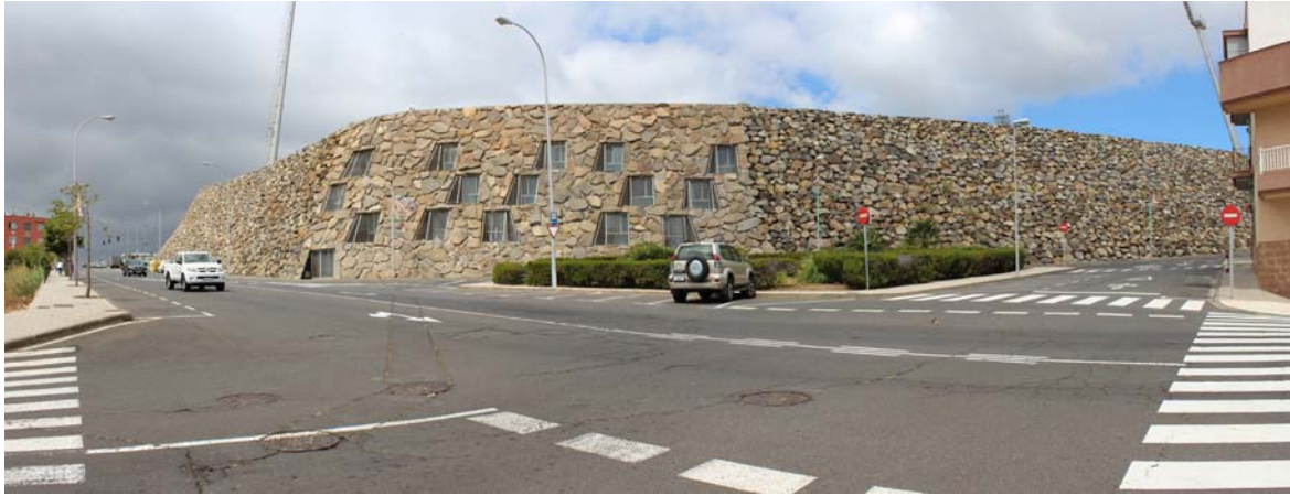
figura14_perspectiva del la parte habitable del talud desde la calle
