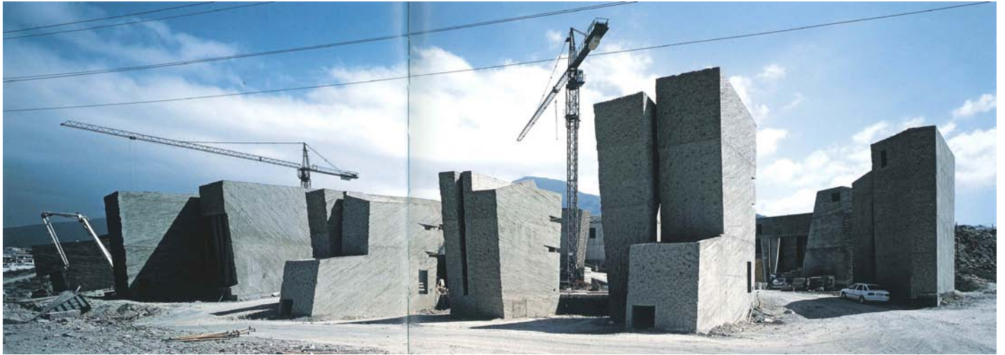
figura6_el MAGMA en construcción, los monolitos esperan la llegada de las olas
