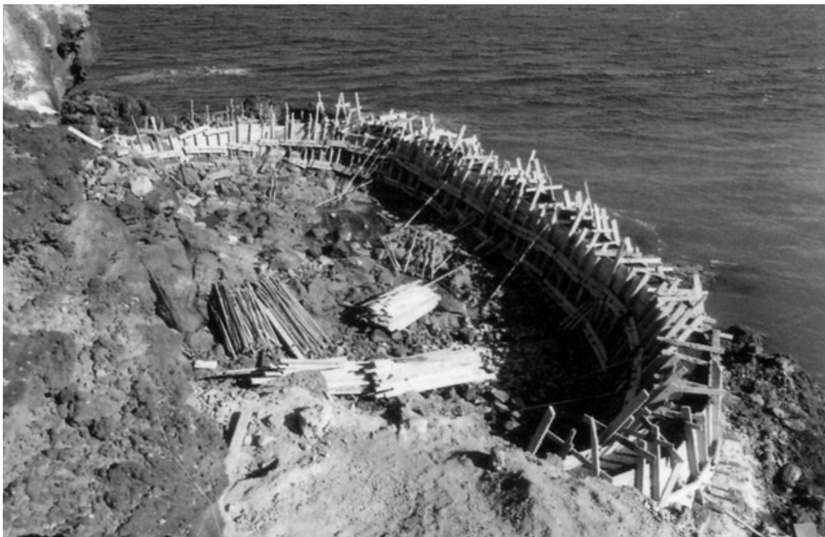
figura5_Construcción mediante encofrado del muro de la piscina
