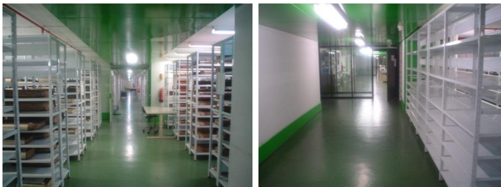
Figura 35. Interior de sala de depósito (Piso 3 Sala 3) onde é possível ver ao fundo, porta «corta-fogo» aberta. Figura 36. Para além das portas dos depósitos, as portas que separam as zonas de serviço onde se encontram as funcionárias e os depósitos, também se encontram abertas em alguns pisos.
