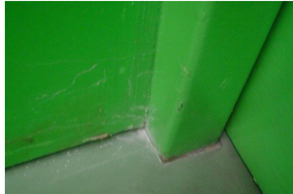
Figura 41. Teia de aranha com insectos mortos, existente numa das janelas da sala. Figura 42. Rodapé não calafetado.
