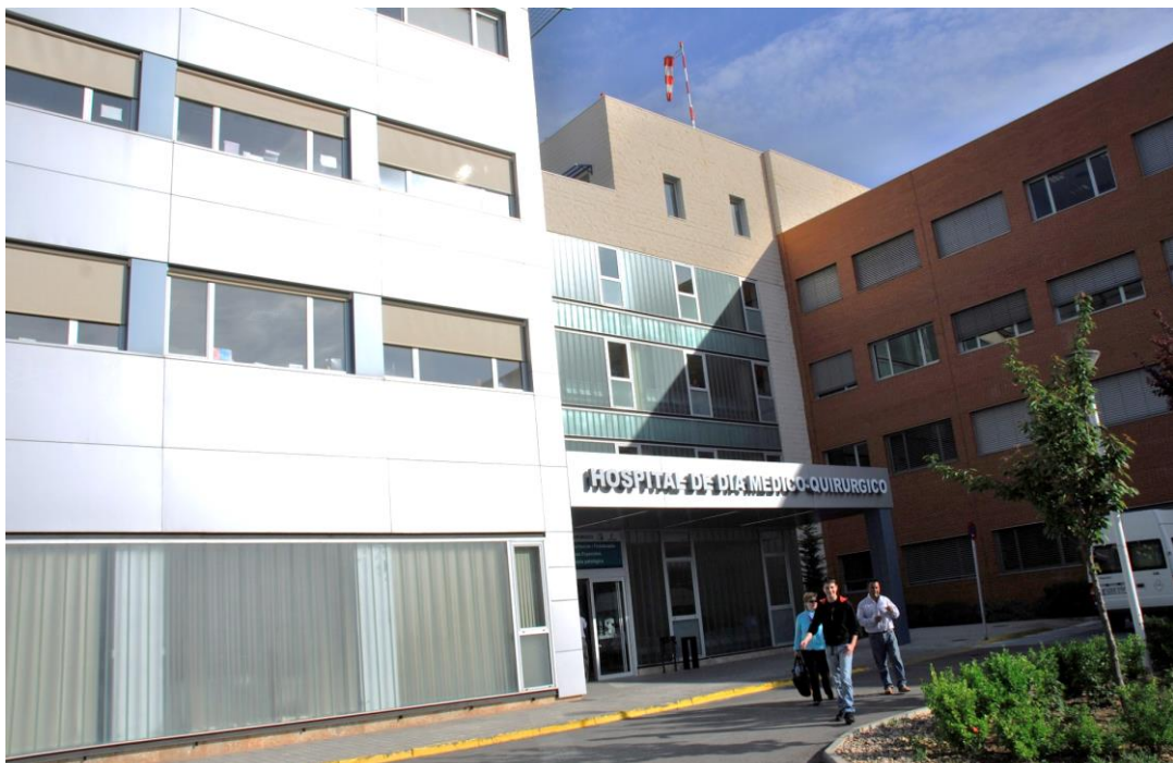
Frontis de la UCSI del Hospital General La Mancha Centro
