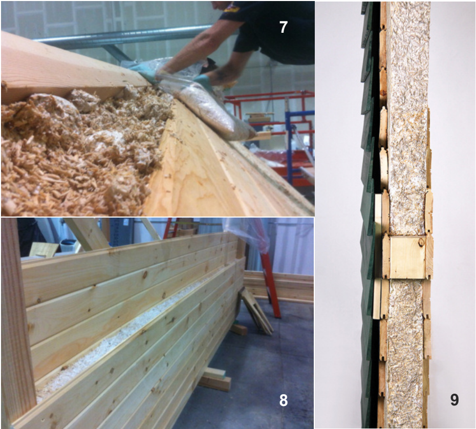
Figs. 7-9: Figs. 7-9. Un prototipo utilizado para realizar las paredes de una casa con micoaislantes
