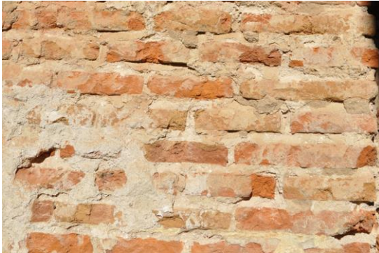
Figura 5: Ladrillo macizo: 4 cm. Mortero: 2 cm.
